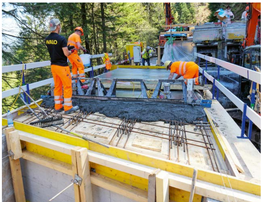
Ausführung der UHFB-Arbeiten: Der flüssige UHFB wird auf die verlorene Schalung eingebracht. Ebenfalls sichtbar das Schubverbundsystem mit GSA-Technologie.
